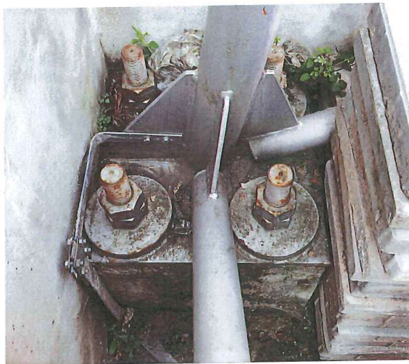
Kotvení věže do železobetonové patky.
