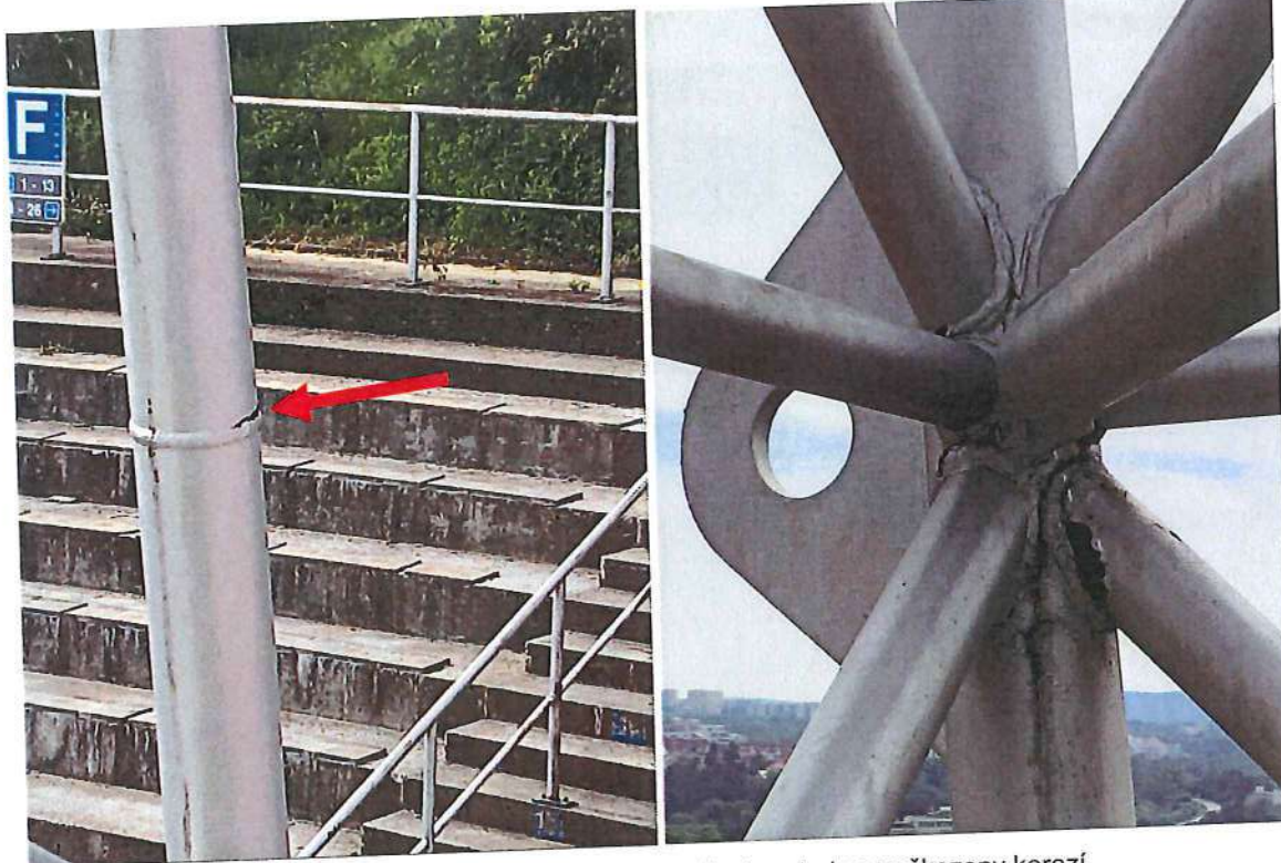
Nutno ověřit detailně svar napojení. Nátěry konstrukce poškozeny korozi.
