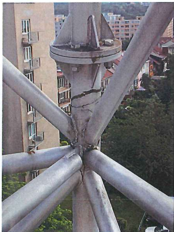
Netypické poškození povrchu kovové konstrukce věže č.1. v místě montážního spoje, v blízkosti styčnicku. Potřebné provést podrobnější prohlídku tohoto detailu za účelem vyloučení deformace prvku.
