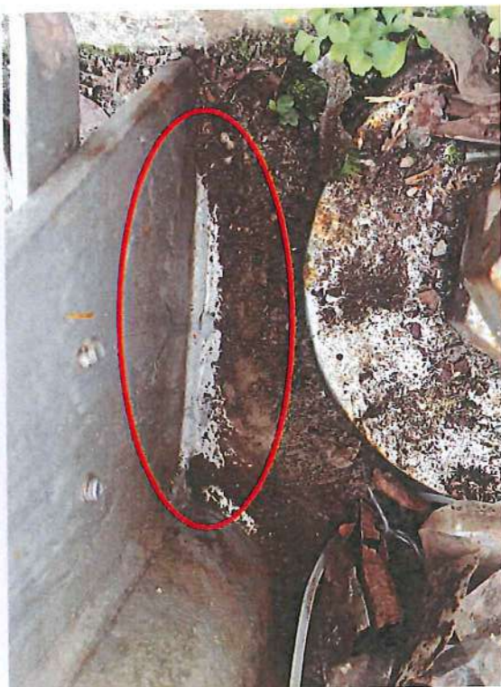
Ocelová kotevní patka věže. Styk patní desky a výztuhy. Nutno ověřit svar patní desky a výztuhy, po vizuální prohlídce je patrné možné porušení svaru styku-vyznačeno červenou šipkou.
