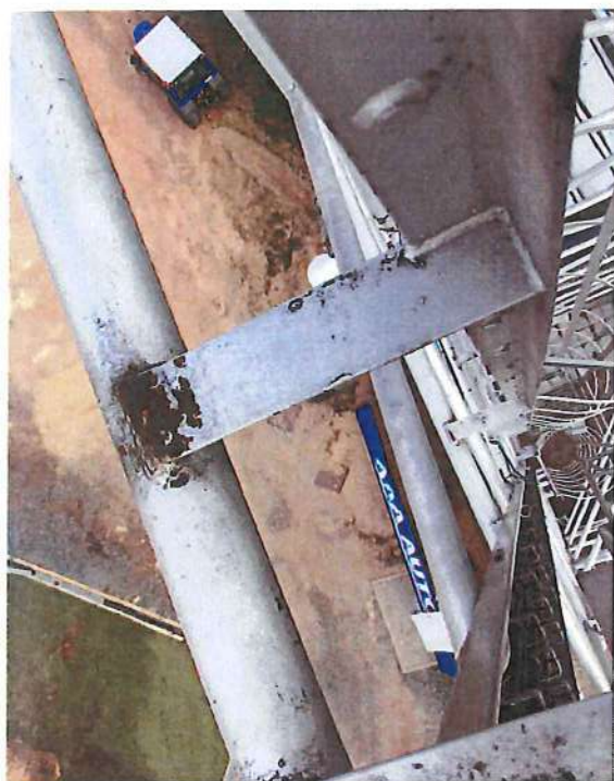
Příhradová kovová konstrukce vykazuje poškození povrchových nátěrů.
