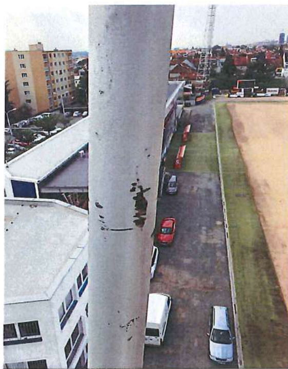
Příhradová kovová konstrukce vykazuje poškození povrchových nátěrů.
