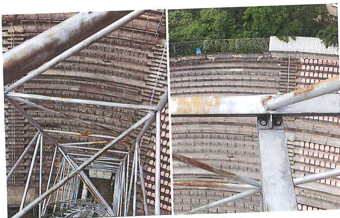
Poškozený povrch konstrukce věže korozi
