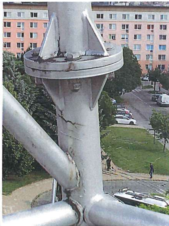
Netypické poškození povrchu kovové konstrukce věže č.1. v místě montážního spoje, v blízkosti styčnicku. Potřebné provést podrobnější prohlídku tohoto detailu za účelem vyloučení deformace prvku.
